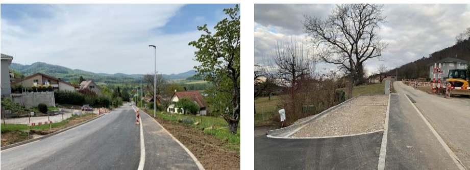
Abbildung 37: sanierte Metzlerlenstrasse mit Trottoir
