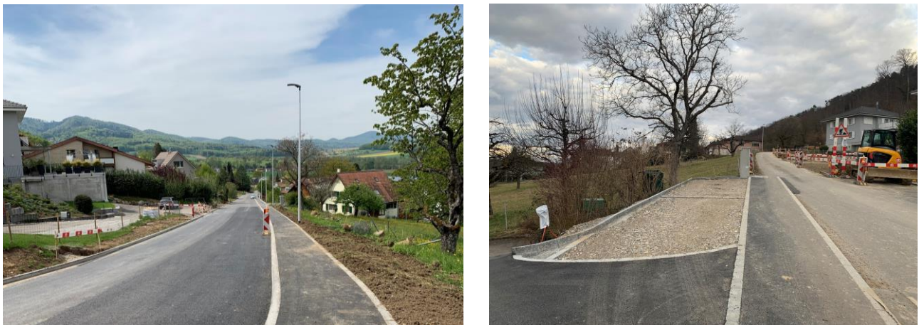
Abbildung 37: sanierte Metzlerlenstrasse mit Trottoir
