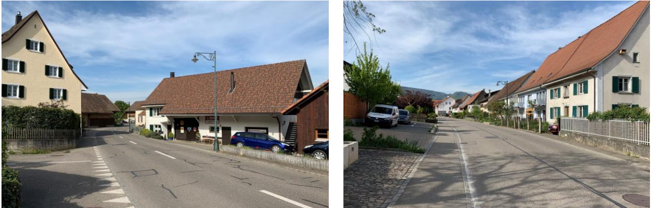
Abbildung 8: Landwirtschaftsbauten, gut ersichtlich ist die schräge Ausrichtung auf die Leimenstrasse (links) und die Biederthalstrasse (rechts)
