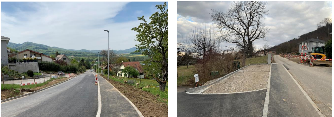
Abbildung 37: sanierte Metzlerlenstrasse mit Trottoir
