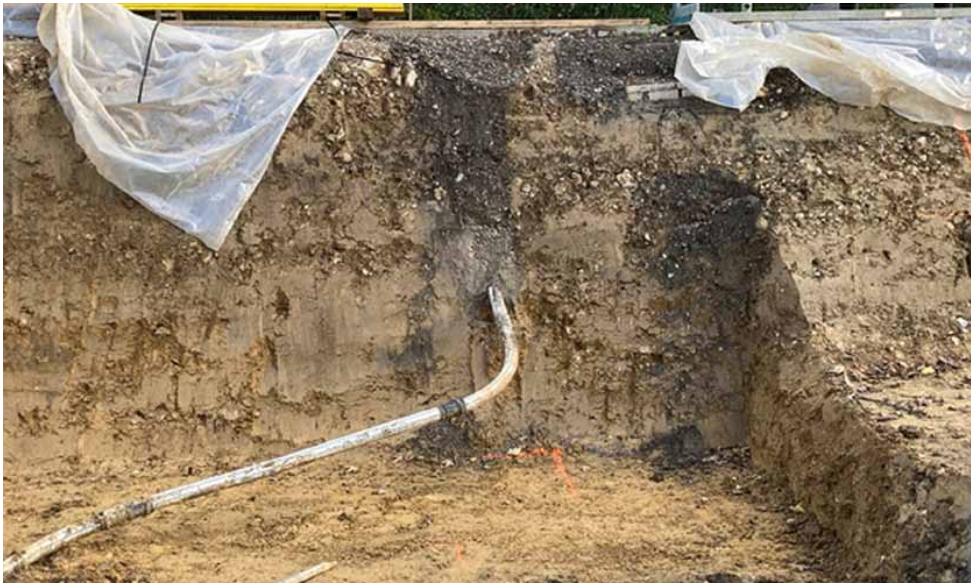
Baustelle unterhalb der Stockackerstrasse, Herbst 2022
